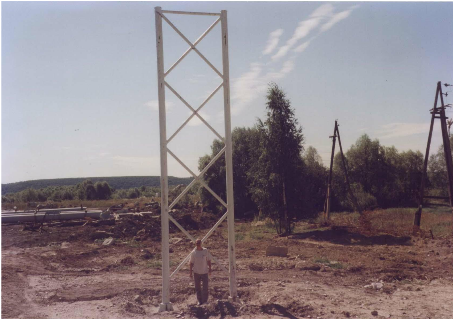
3-я промежуточная опора (высота 8.2 м) Рис. 3.5
