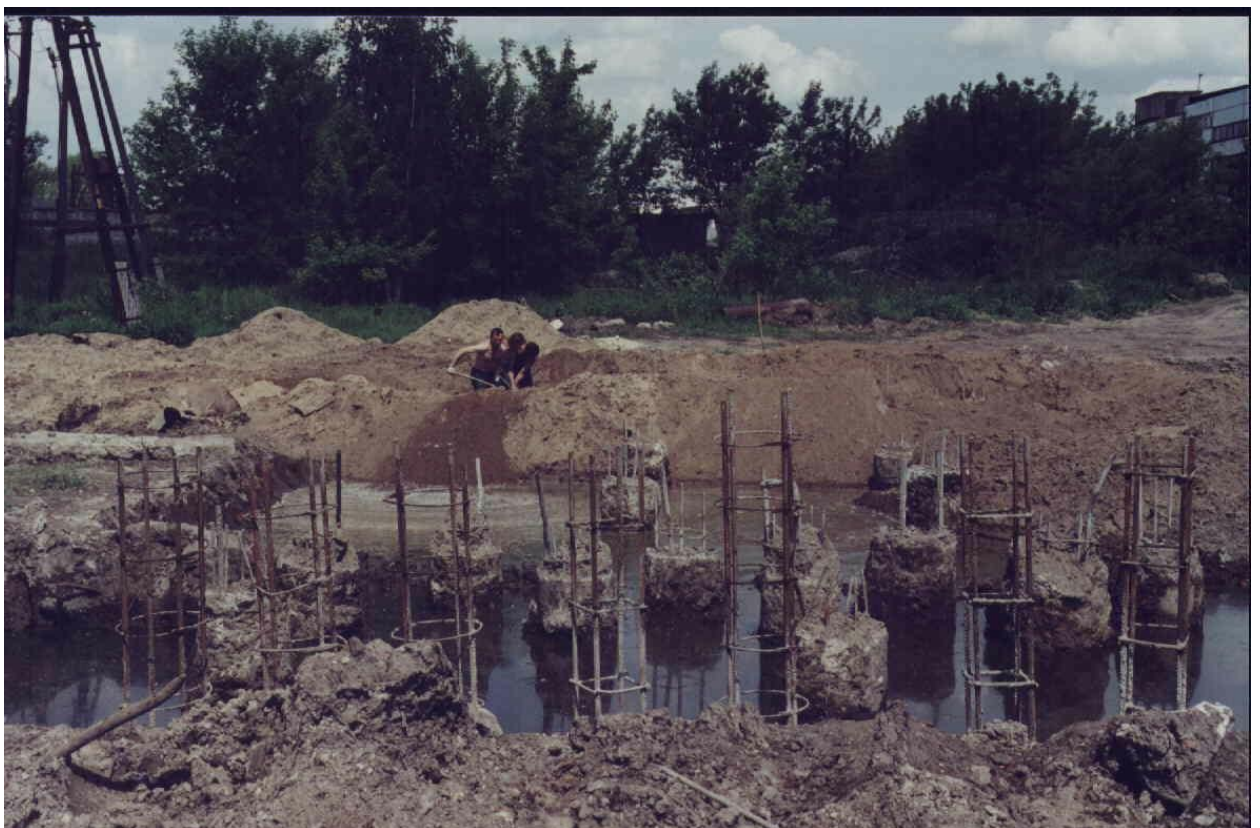
Буронабивные сваи большой анкерной опоры Рис. 3.7
