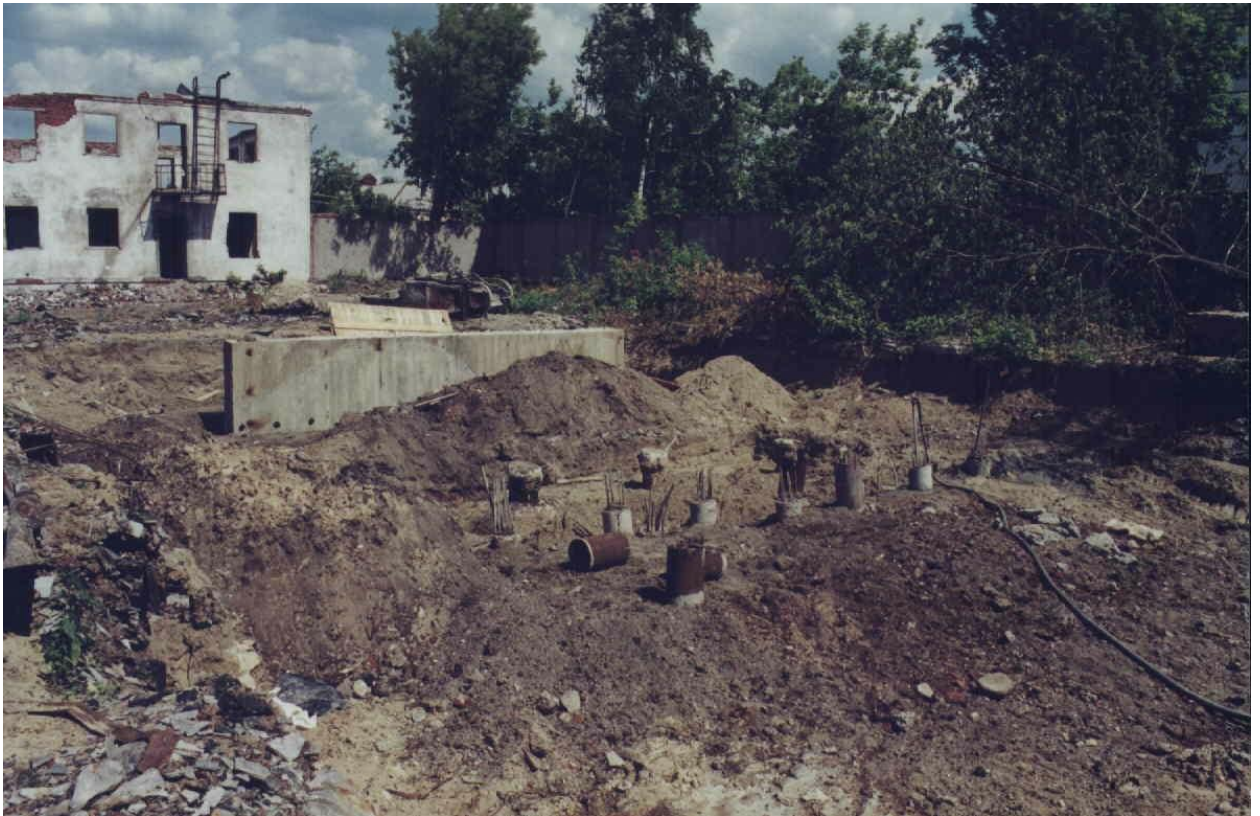
Буронабивные сваи малой анкерной опоры Рис. 3.6
