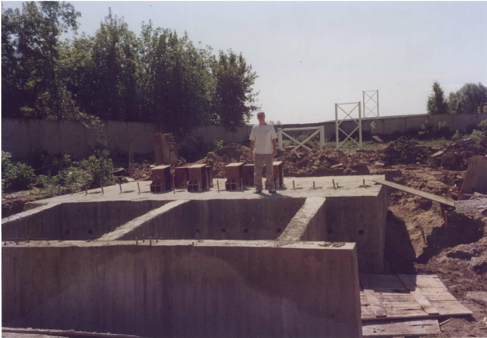
Фундамент малой анкерной опоры (высота 1 м) Рис. 3.8
