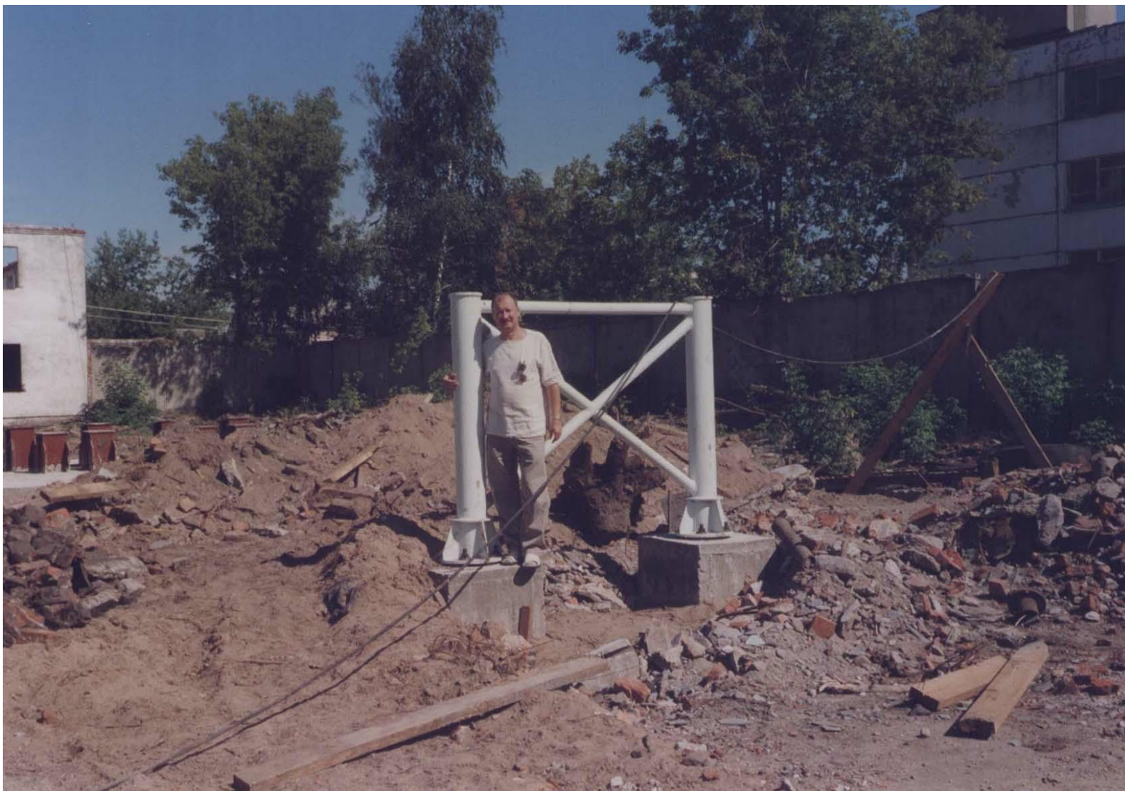
1-я промежуточная опора (высота 2.2 м) Рис. 3.3
