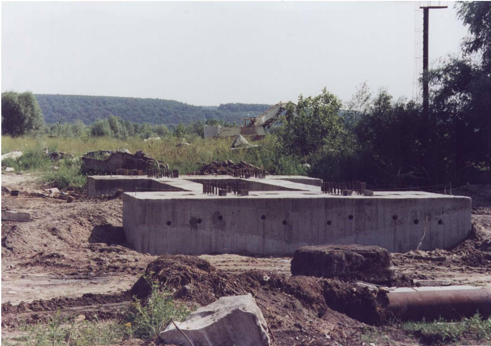
Фундамент большой анкерной опоры (высота 15 м)
