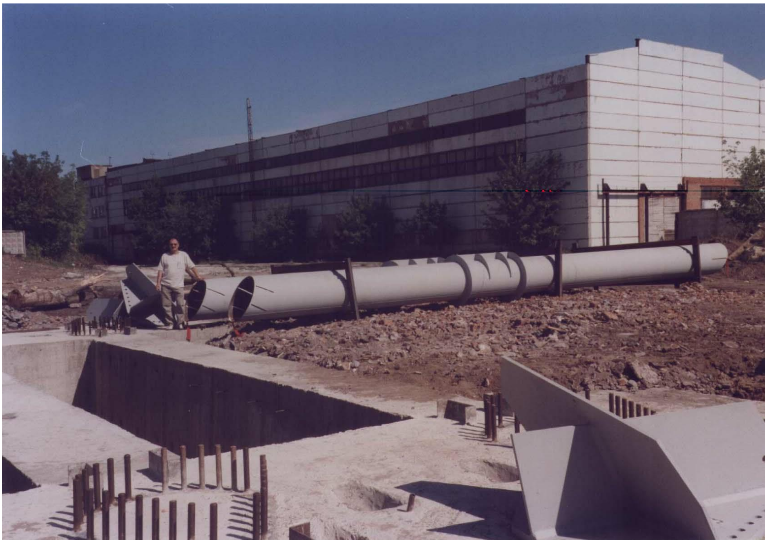
Фундамент большой анкерной опоры, подготовленной к монтажу Рис. 3.10
