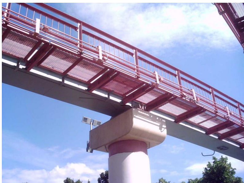
Рис. 10. Опора московского монорельса
