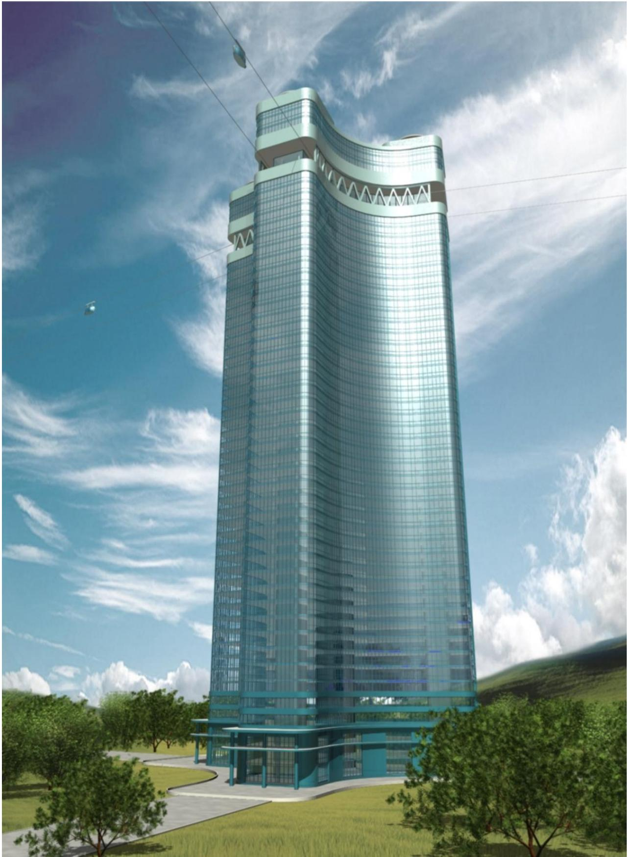
Рис. 6.2. Общий вид здания, совмещенного со станцией моноСТЮ «Комсомольская» (общая высота здания 170 м, площадь застройки 1500 кв. м, количество этажей 45-50, этаж на отметке 150 м занимает станция моноСТЮ, этаж на отметке 145 м занимает сервисное депо моноСТЮ)
