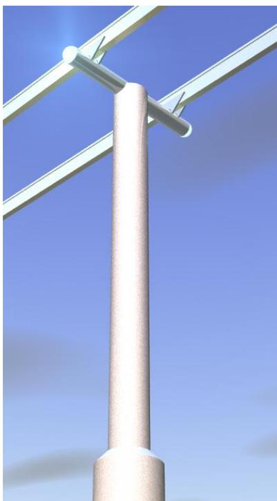
Рис. 1.9. Промежуточная железобетонная поддерживающая опора одного пути бирельсового СТЮ с вмонтированным в нее освещением
