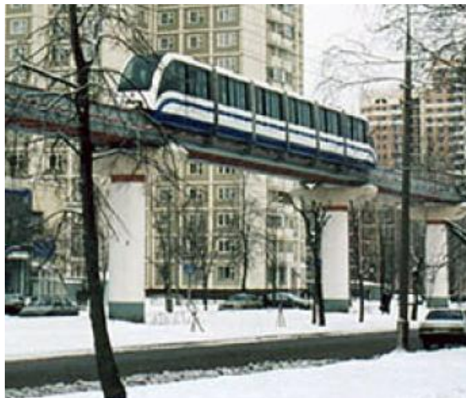
Рис. 1.46. Шестивагонный состав московской монорельсовой транспортной системы
