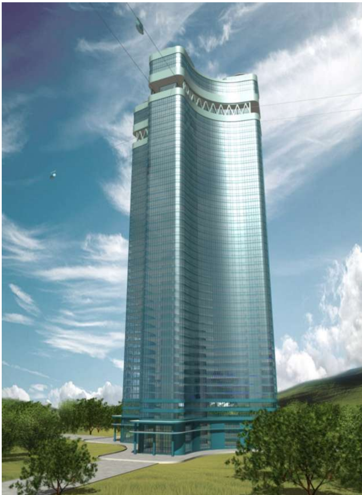
Рис. 4. Общий вид одного из возможных вариантов здания, совмещенного со станцией моноСТЮ, на пересечении трех двухпутных трасс моноСТЮ (общая высота здания 130 м, площадь застройки 1500 м 2 , количество этажей 40—45, этаж на отметке 110 м занимает станция моноСТЮ, этаж на отметке 105 м занимает сервисное депо моноСТЮ)
