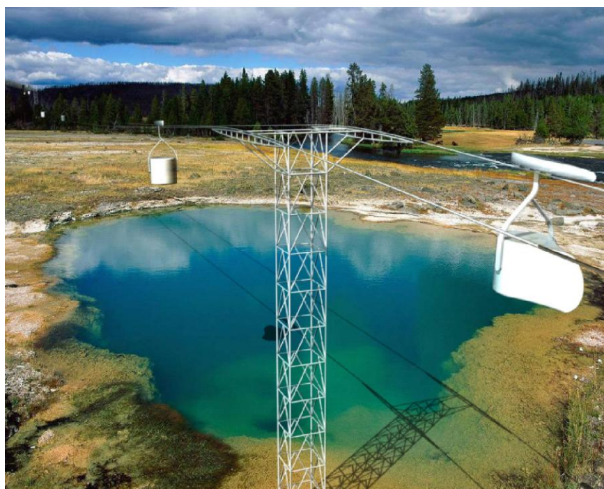
Рис. 4. Скоростная двухпутная однорельсовая трасса СТЮ — моноСТЮ (скорость до 120 км/час)
