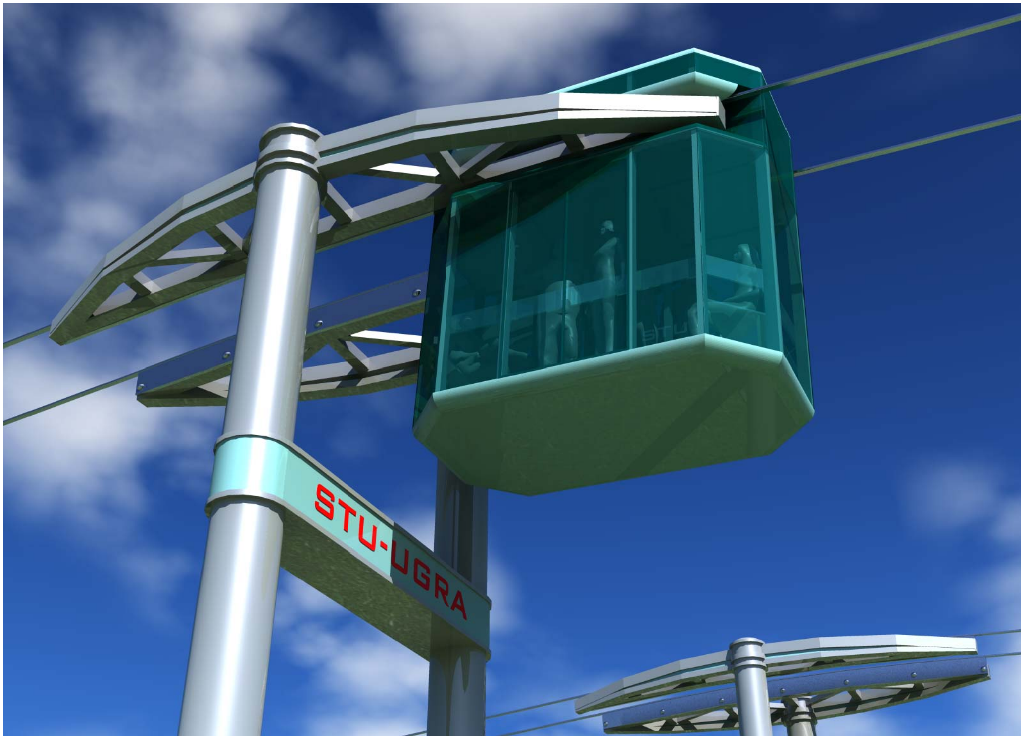
Первая очередь. Промежуточная опора. Вариант 2 (пролёт 250 + 250 м)
