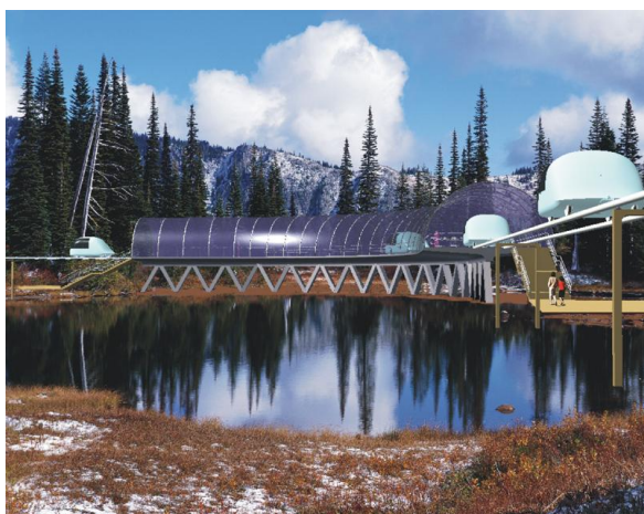
Рис. 24. Поворотная анкерная опора навесного СТЮ, совмещённая со станцией
