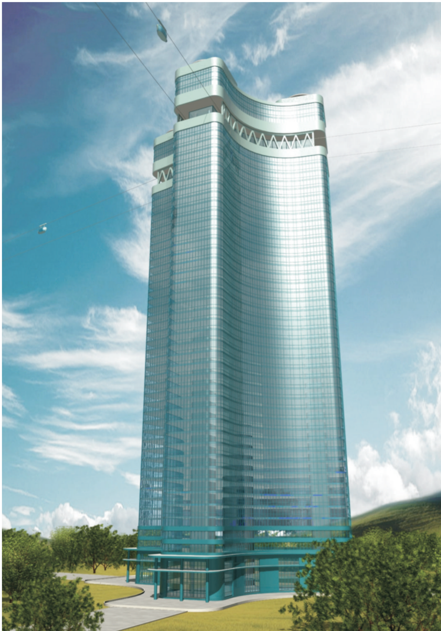
Общий вид поворотной станции СТЮ, совмещенной с высотным жилым домом
