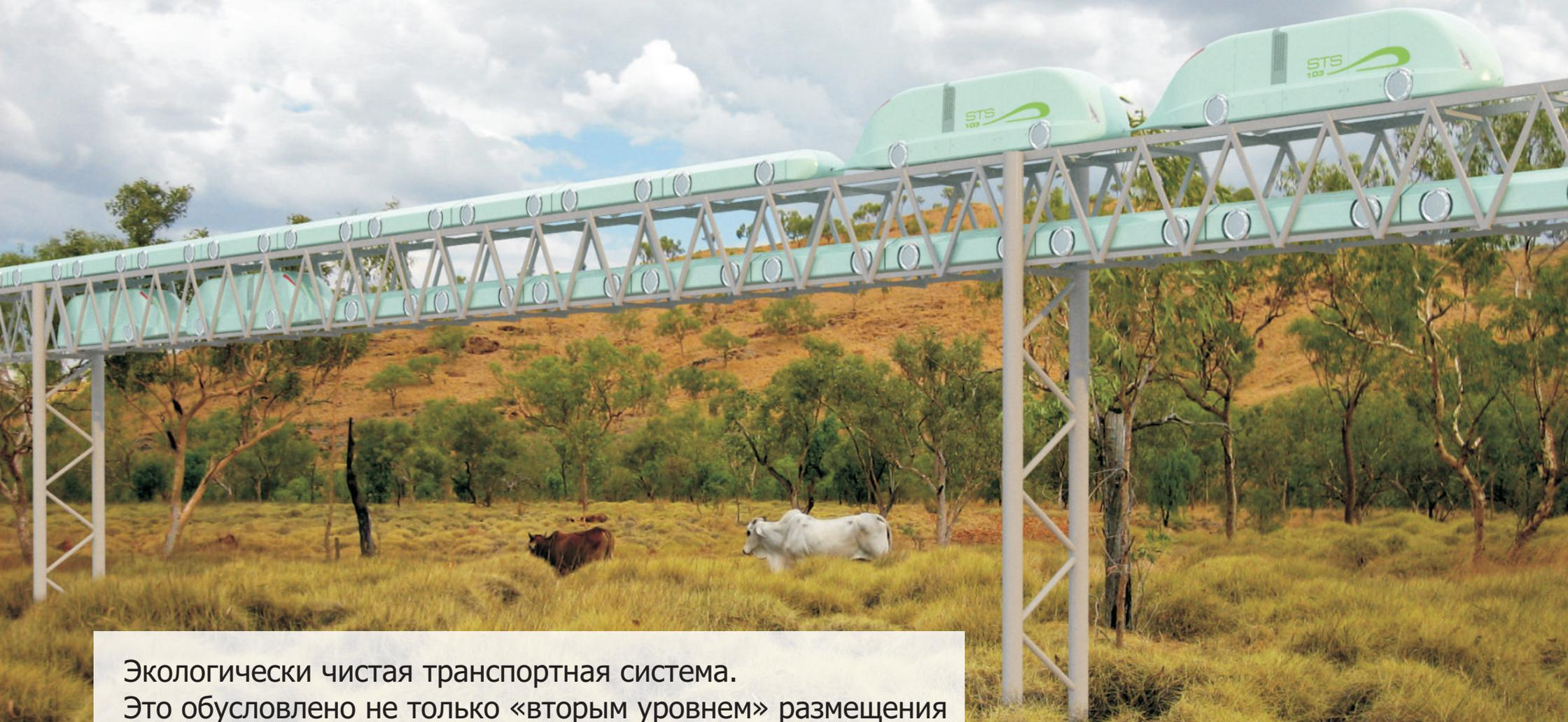
Экологически чистая транспортная система. Это обусловлено не только «вторым уровнем» размещения путевой структуры (отсутствуют насыпи, выемки, мосты, путепроводы и др.), но и — низкой ресурсоёмкостью и энергозатратностью как на стадии строительства, так и при эксплуатации системы.
