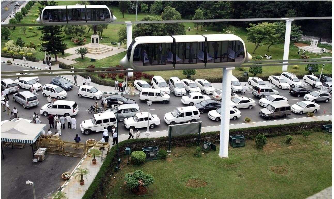
Рис. 5. Двухпутная трасса городского навесного СТЮ (скорость до 150 км/час)
