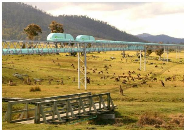
Рельсо-струнная путевая структура не имеет стыков и деформационных (температурных) швов и отличается идеальной прямолинейностью и плавными изгибами, что имеет принципиальное значение для достижения самых высоких эксплуатационных показателей транспортной системы — высоких скоростей движения, минимальных ударных нагрузок, низких затрат энергии.
