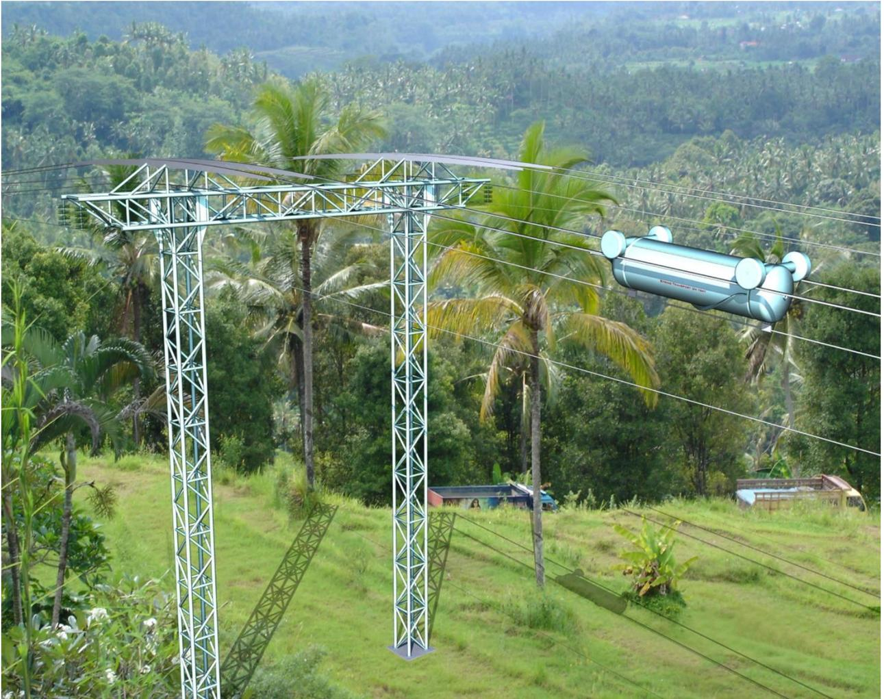
Рис. 7. Линии электропередач и связи, совмещённые с перевозкой контейнеров
