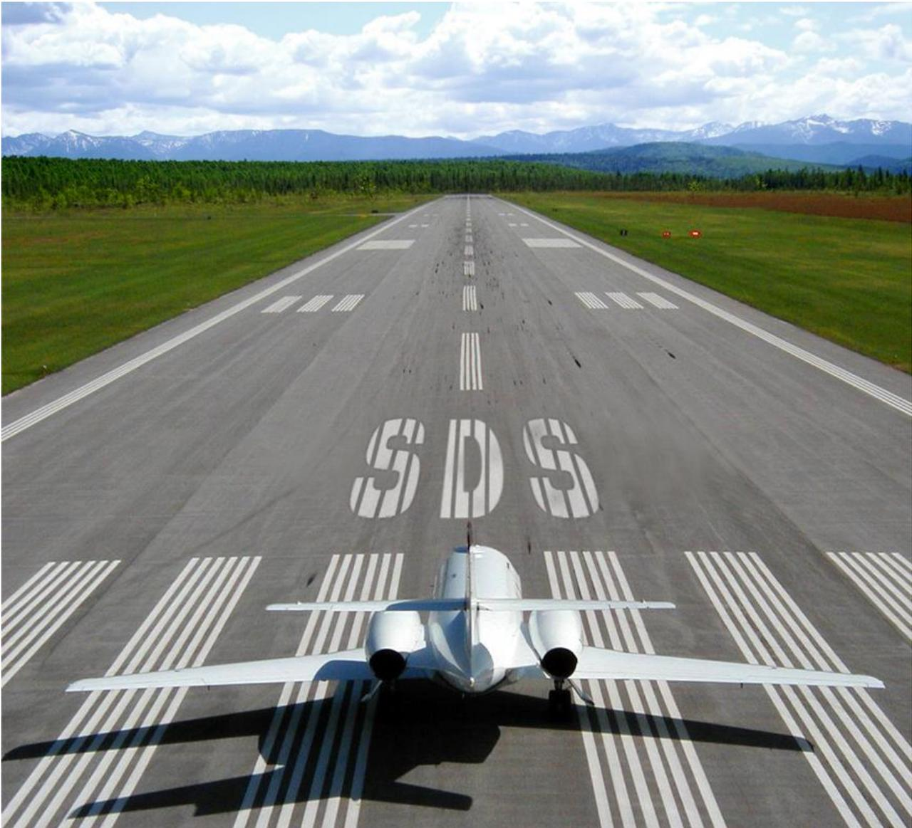
Рис. 11. Струнная взлётно-посадочная полоса аэропорта, построенная без температурных швов (продольных и поперечных)
