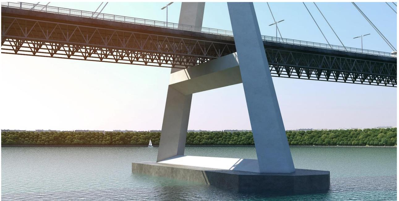
Рис. 10. Вид на продольные струнные фермы, на которых размещено дорожное полотно вантового моста
